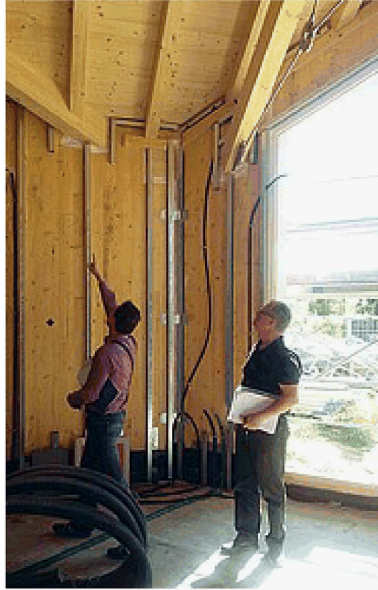
Qualità Controlli durante la costruzione di un edificio prefabbricato di Sistema casa Fiemme, fornito da Rasom
